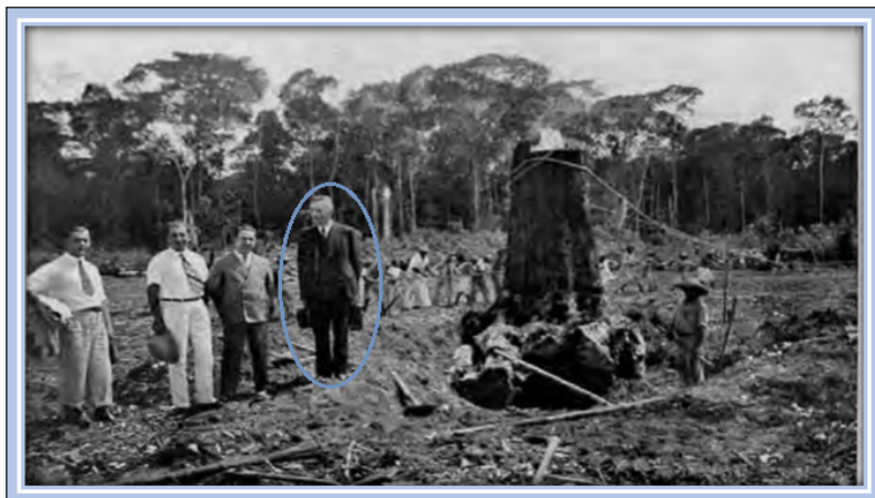
Imagem 2: Limpeza do espaço onde seria construído o Hospital Colônia de Marituba.
