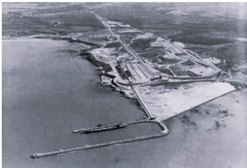
Imagem 17: construção do Porto de Tubarão da Companhia Vale do Rio Doce, em Vitória-ES, cuja conclusão se deu em 1966. Fonte: Sítio eletrônico da Vale.
