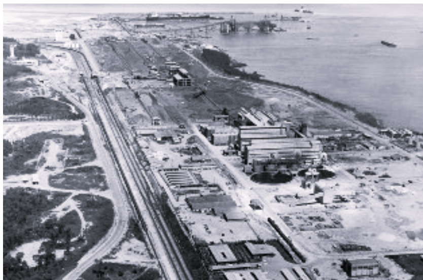
Imagem 18: instalação da primeira usina de Pelotização da CVRD no Porto de Tubarão – 1969. Fonte: Sítio eletrônico da Vale.
